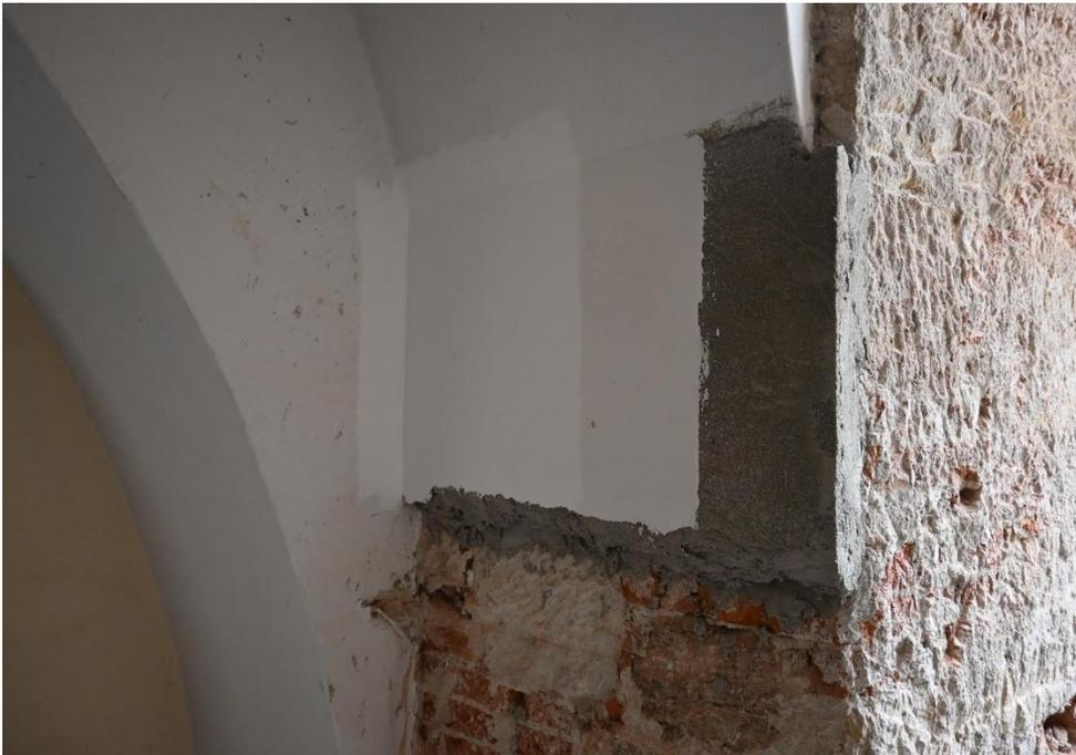
Zugestimmt wurde ebenfalls der Anbringung von Wärmedämmputz. Hier sehen Sie eine Musterfläche.
