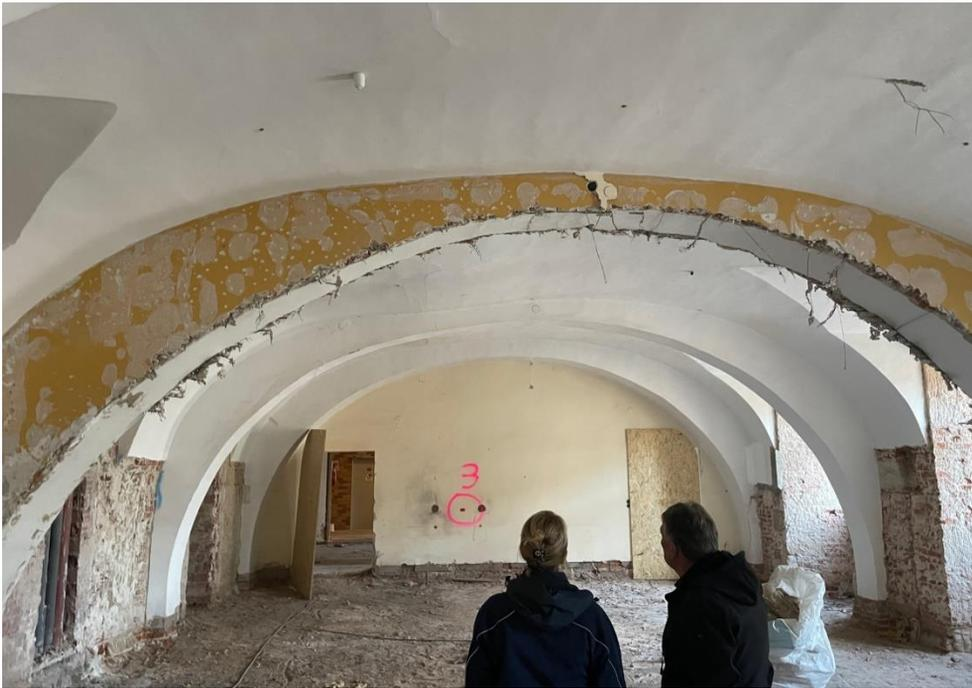
Die Gewölbestructuren sind komplett freigelegt. Der Zustand wird durch die Tragwerksplaner untersucht.
