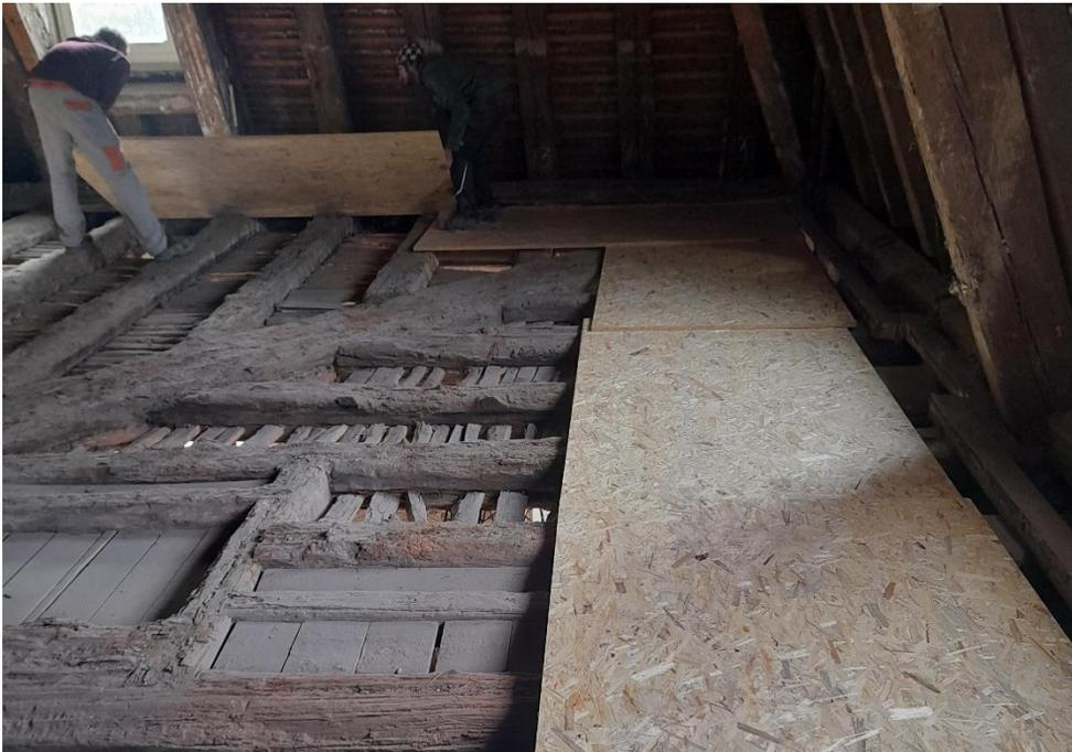
Die freigelegten Holzbalkendecken werden für die sichere Begehbarkeit bei den anstehenden Arbeiten mit Holzplatten ausgelegt.
