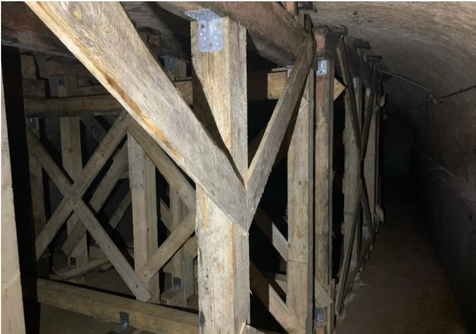
Sobald die Bodenplatte betoniert und fest ist, wird sie von den Bohrpfählen getragen. Die Keller werden in der Zwischenzeit zusätzlich durch eine Holzaussteifung unterstützt.
