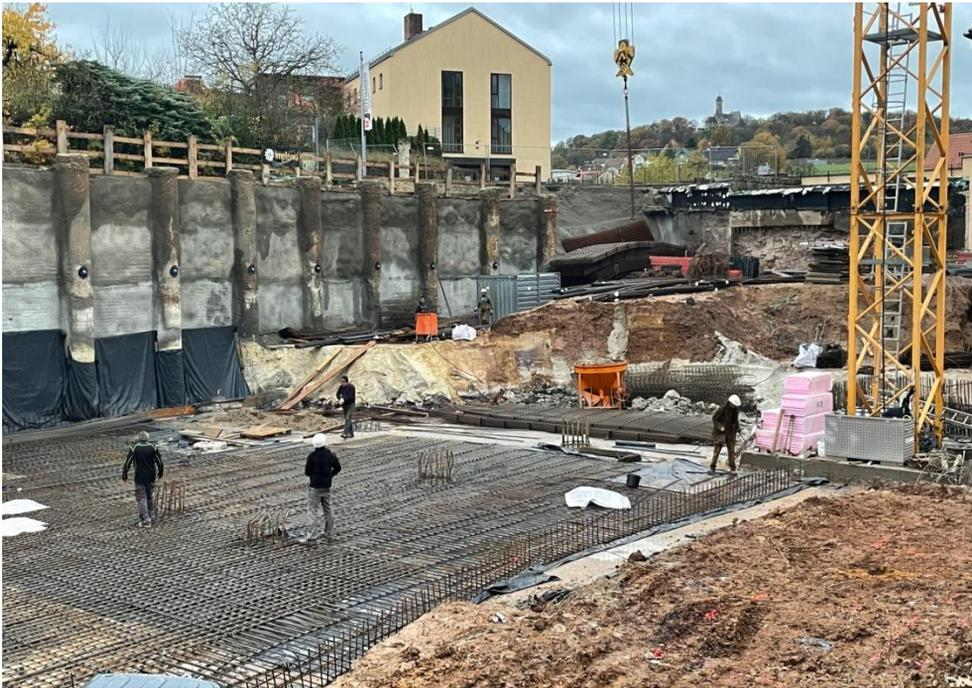
Die Platte liegt an der Westseite auf zusätzlichen Bohrpfählen auf. An der herausragenden Bewehrung sind die Pfahlköpfe erkennbar.
