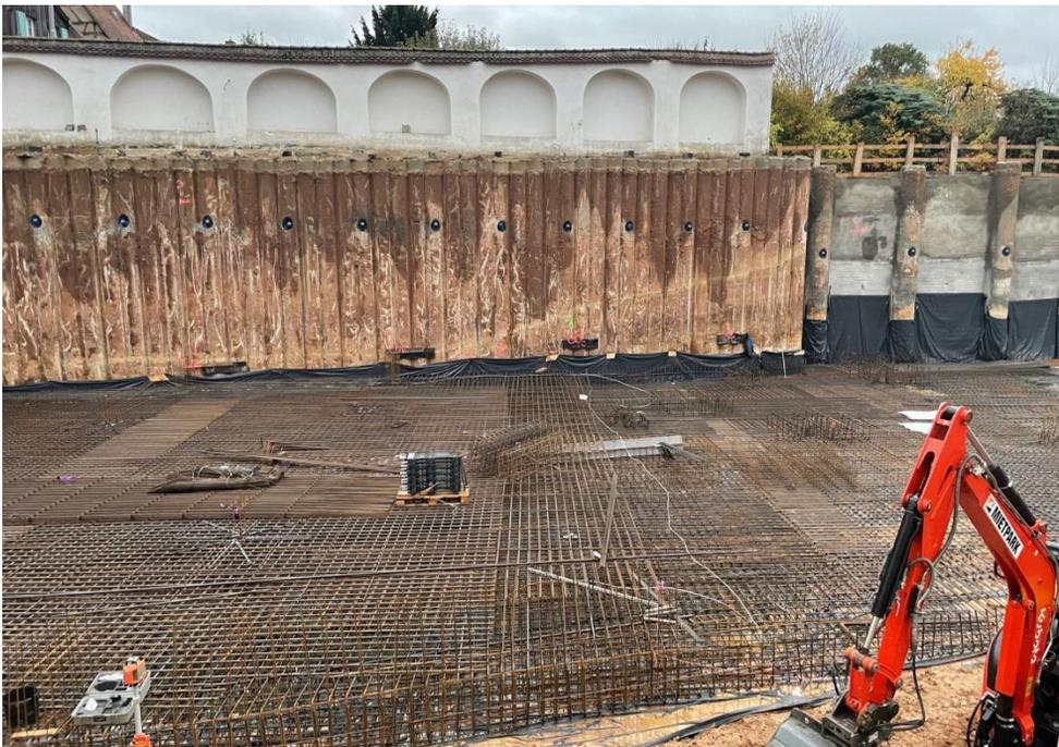
Hier sehen Sie den Mittelteil der Baugrube. Wenn die obere Bewehrungslage fertig ist, kann ein Teil der Bodenplatte betoniert werden.
