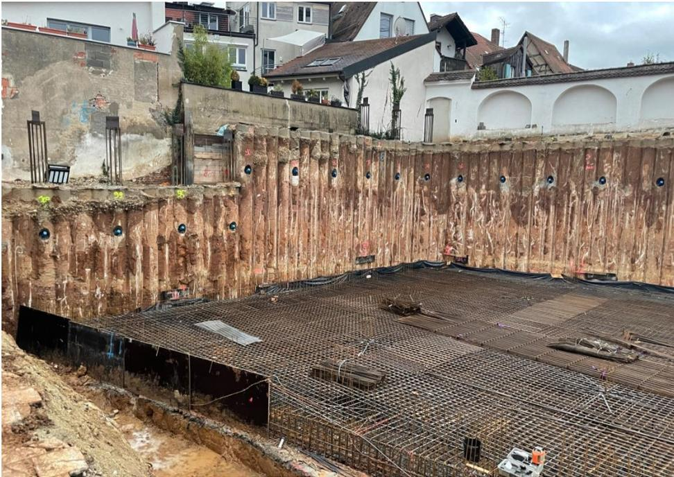
Am östlichen Ende der Baugrube der Tiefgarage wurde die Bewehrung der Bodenplatte weitgehend fertiggestellt.
